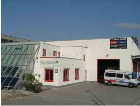
Die neue Produktionshalle in Schorndorf ist nach hohen Umweltauforderungen gebaut.
