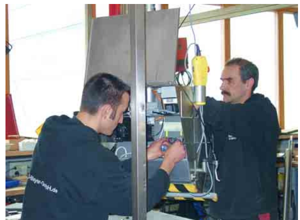
Eine verfahrbare Monitoranlage wird von Mitarbeitern der S. Bleyer GmbH verkabelt.
